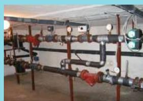
При необходимости, установка/модернизация автоматизированного индивидуального теплового пункта, включая балансировку системы отопления
